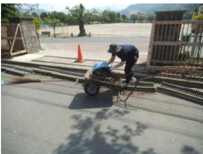
間隔を広くとっての作業
